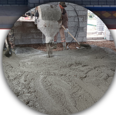
Пол из керамзитобетона по керамзиту
