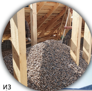
Утепление кровли керамзитом
