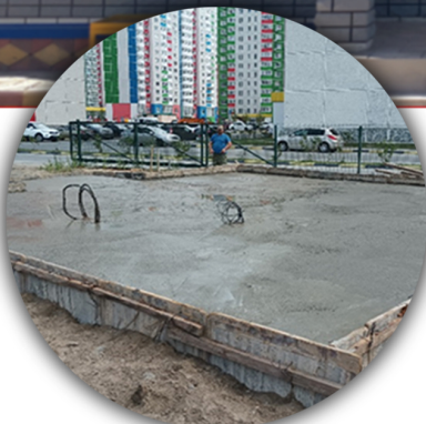
Фундамент из керамзитобетона
