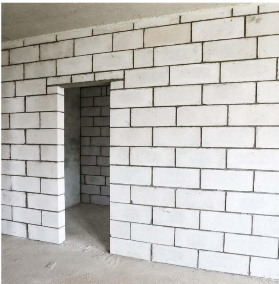
У керамзитоизвесткового блока теплопроводность ниже, чем у тяжелого бетона, поэтому температура распространяется вглубь конструкции медленнее и дольше времени арматура остается защищенной от пожара.
